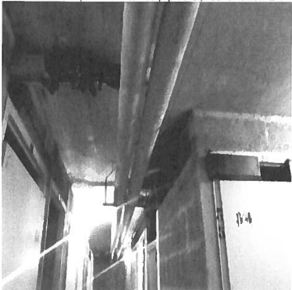
montée 12 rdc / couloir caves / plâtre / échantillon 1 :
