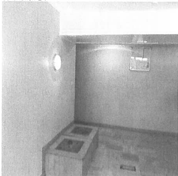
montée 12 rdc / hall d'entrée / enduit projeté peint / échantillon 2 :
